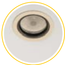
1. Oude plafondbouwarmatuur met grotere plafonduitsparing.
