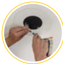
5. Elektrische aansluiting en installatie van de nieuwe plafondbouwarmatuur.
